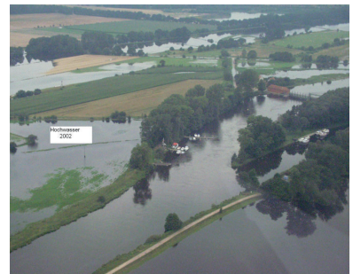
Marklendorfer Schleuse und Wehr bei Hochwasser
