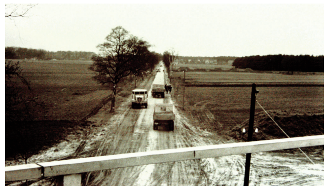
Autobahnbau 1957, Brücke B214 Blick Richtung Buchholz
